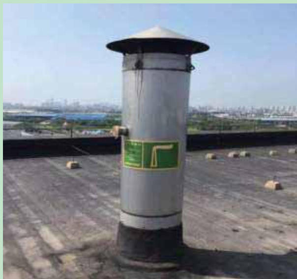
图 2.4-1 喷雾干燥废气排放口
